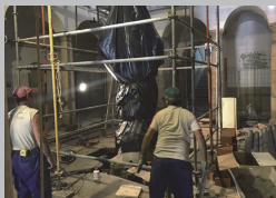
Estado de las obras
